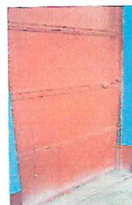
Foto 6: Sustitución de una puerta.
