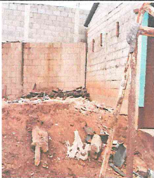
Foto 5: Construcción de cocina para la alimentación escolar.
