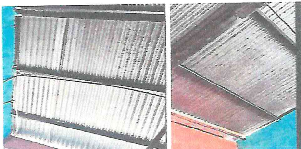
Foto 1: Sustitución de lamina por lamina troquelada.
